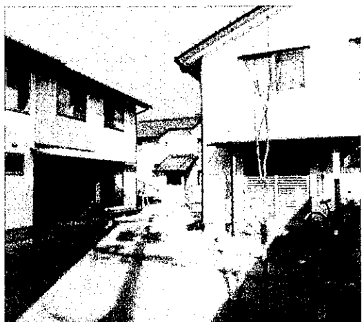
■外観（南側から敷地内通路）
