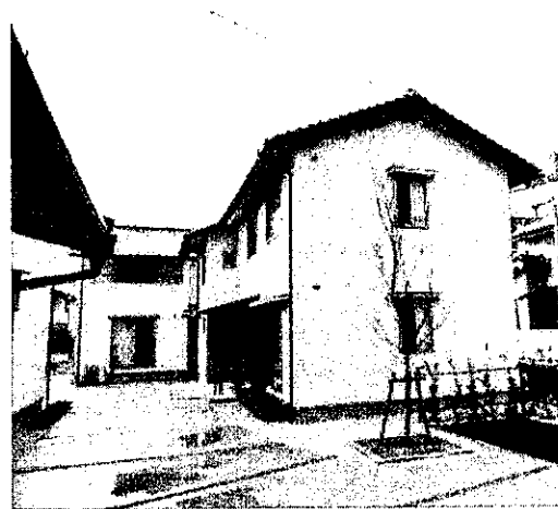
■共用空間（北側から）
